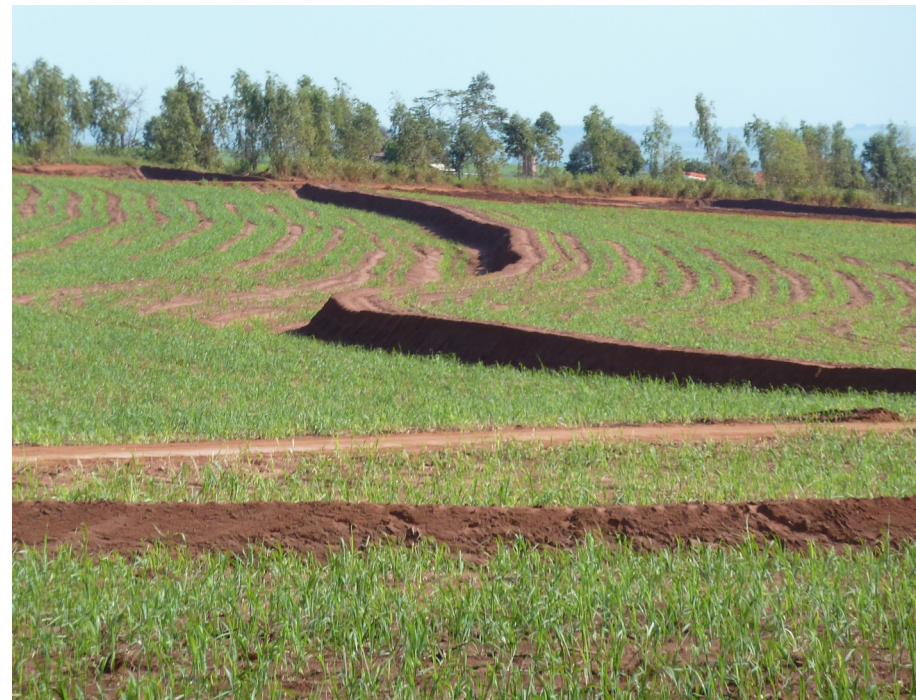
Área em recuperação – Após conclusão de Obras. Nova Aliança do Ivaí, - DEPOIS FDA Haroldo L. M. Porto
